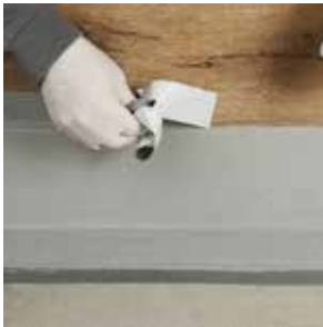
Afplaktape boven en onder verwijderen
