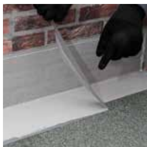
Afplaktape boven en onder verwijderen
